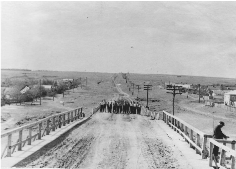
снимок 1959 года. Отремонтированный старый мост. Вид на Кузьминовку.
