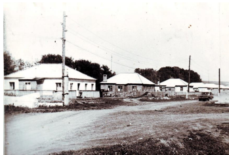
новые двухквартирные дома
