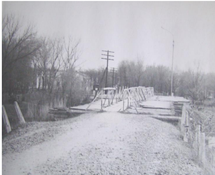
Восстановление старого моста
