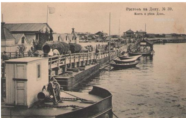
Мост через Дон, который позволил перенести дорогу от Аксая в Ростов через Батайск.
