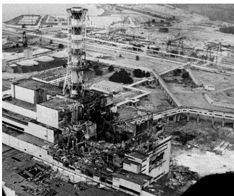
Разрушенный четвертый энергоблок
