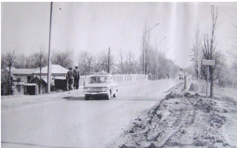
Асфальтированная дорога по Кольцовскому переулку и новый мост
