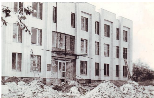
Строительство здания Райкома КПСС 1981 год
